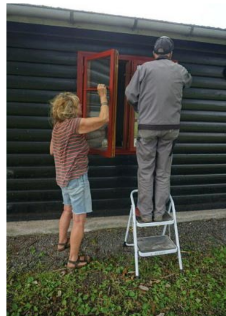
Rika og Jens lægger sidste hånd på sidste vindue.
